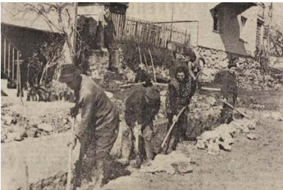
Slika 2 Zgoraj: Gradnja glavnega kanalizacijskega voda v vasi (hrani: Zgodovinski arhiv Ljubljana, enota za Dolenjsko in Belo krajino, Kronika OŠ Otočec 1963/64). Spodaj: Kopenje vodovoda (vir: Dolenjski list, 16. 4. 1970, str. 24).
